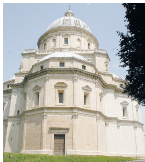
Il tempio della Consolazione
