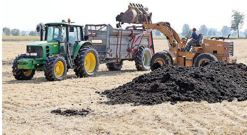
Fanghi in agricoltura: la società Ecotrass di Bergamo ha presentato un piano per il trattamento
