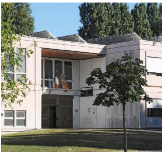
La scuola media di Casette sottoposta a verifiche antisisma DIENNE
