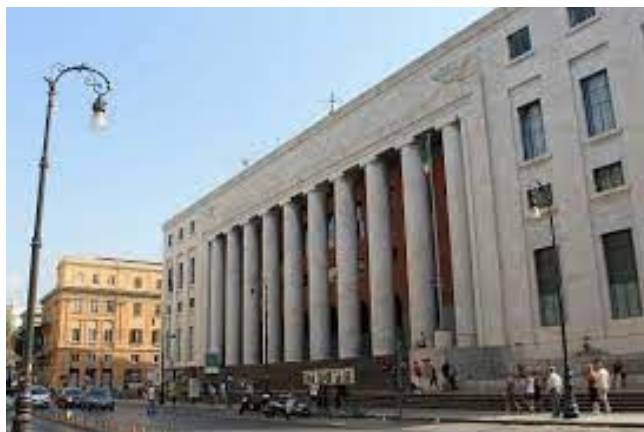
Palermo, Poste Centrali di Via Roma
